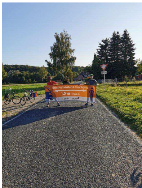
Gemeindeverbindungsstraße Lübberstedt - Gödenstorf
